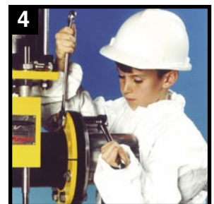
4 Reemplazar flanges de apoyo y pernos de flanje de manga
